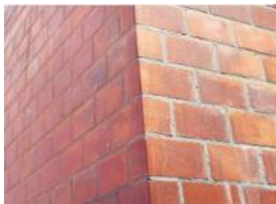
PAREDES BLOCOS CERÂMICOS
