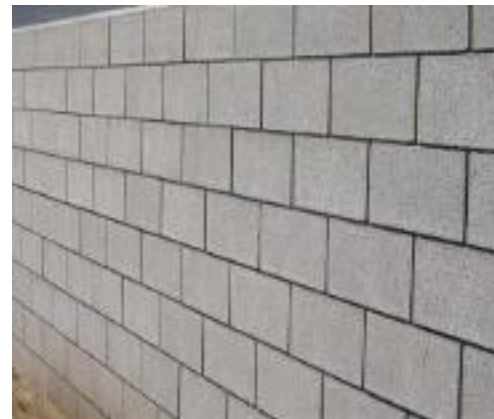
PAREDES BLOCOS DE CIMENTO
