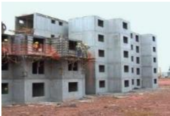
PAREDES DE CONCRETO
