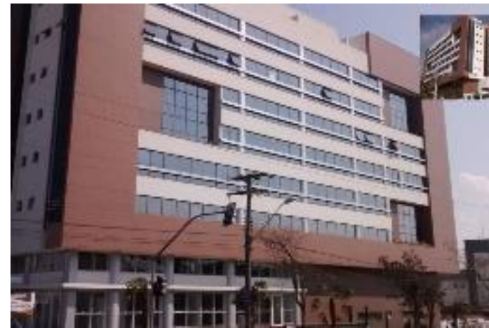
FACHADAS DE ACM
