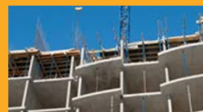
CONCRETO MOLDADO IN LOCO, USINADO E PRÉ-FABRICADO
