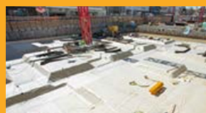
IMPERMEABILIZAÇÃO DE SUBSOLOS
