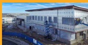
REVESTIMENTOS DA CONSTRUÇÃO
