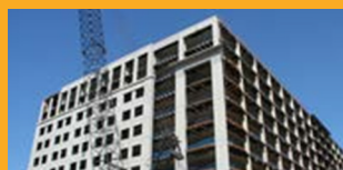
REPARO DE CONCRETO
