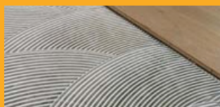
INSTALAÇÃO DE REVESTIMENTOS
