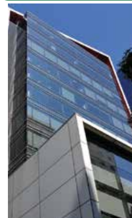
Figura 8: Exemplos de fachadas com dois diferentes tipos de vidros de controle solar: um com maior transmissão luminosa (esq.) e outro com maior reflexão (dir.)
